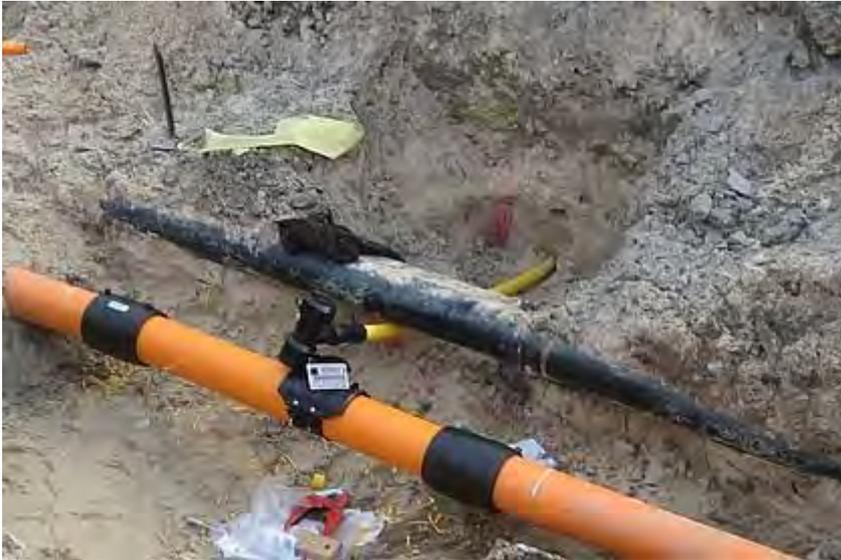
Eine massive Störung im Gasnetz in Lichtenau und Holtheim beschäftigt aktuell das Unternehmen Westfalen Weser Netz. Bei Bauarbeiten der Deutsche Glasfaser ist eine Gas-Versorgungsleitung beschädigt worden.
