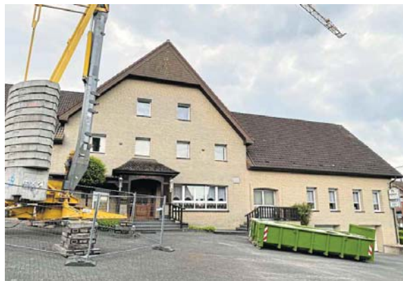
Im Landgasthof wird viel passieren. Mehrere Wohnungen sind geplant.
